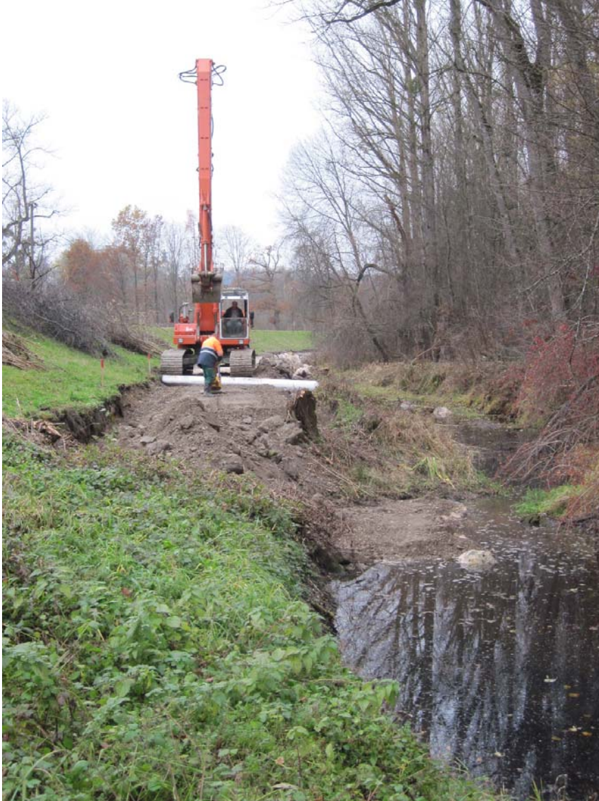
Deichsanierungsarbeiten am Hainacher Deich durch die Flußmeisterstelle Salzach
